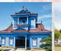
重要文化財 旧鶴岡警察署庁舎
