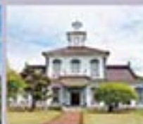
重要文化財 旧西田川郡役所
