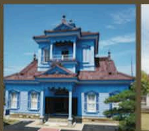
重要文化財 旧鶴岡警察署庁舎
