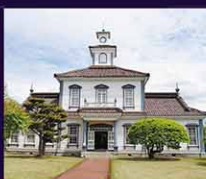
重要文化財 旧西田川郡役所
